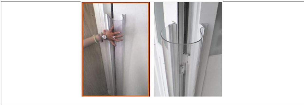
Se instalarán, en cada extremo del PVC flexible, dos perfiles L de aluminio blanco 20x20 mm, uno sobre el otro, y con el PCV en medio. El aluminio irá atollado a la puerta-marco, y se emplearán remaches para sujetar el PVC flexible al sándwich de perfiles de aluminio.
